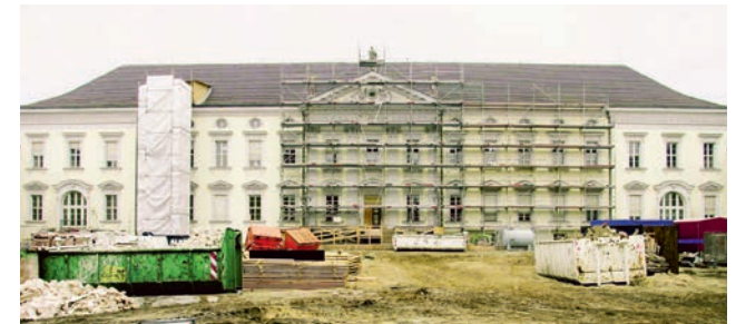
Schloss Bellevue während der Restaurierungsarbeiten 2004/2005
